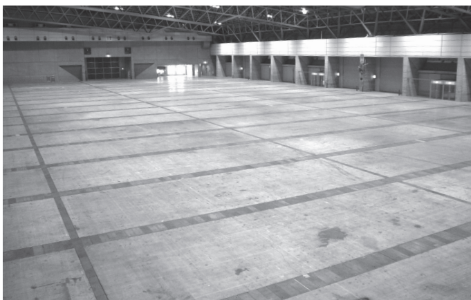
展示ホール床とピット（俯瞰）
