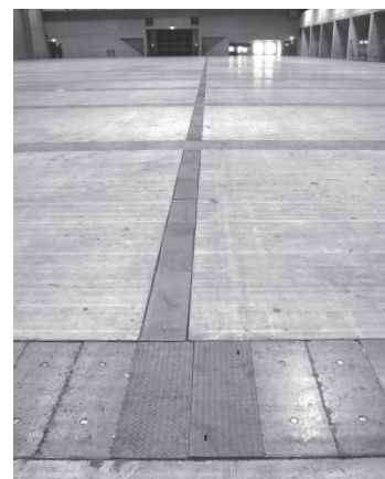
ピットとサブピット
